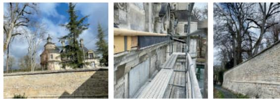
Le premier est la restauration des chéneaux et des corniches de la façade arrière au niveau de la Grande Galerie en Trompe l'œil. L'entreprise 3A Patrimoine qui travaille sur le Château de Maulnes est venue remplacer 7 pierres de corniche endommagées par les infiltrations d'eau et le gel.
